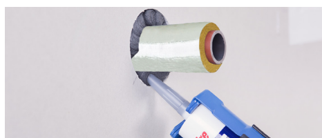
Sellado de tubos metálicos
