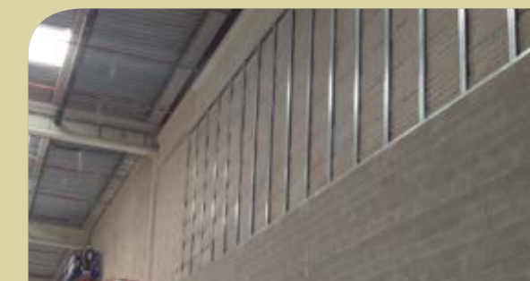
Compartimentación Proyección en interior de tabiquería seca
